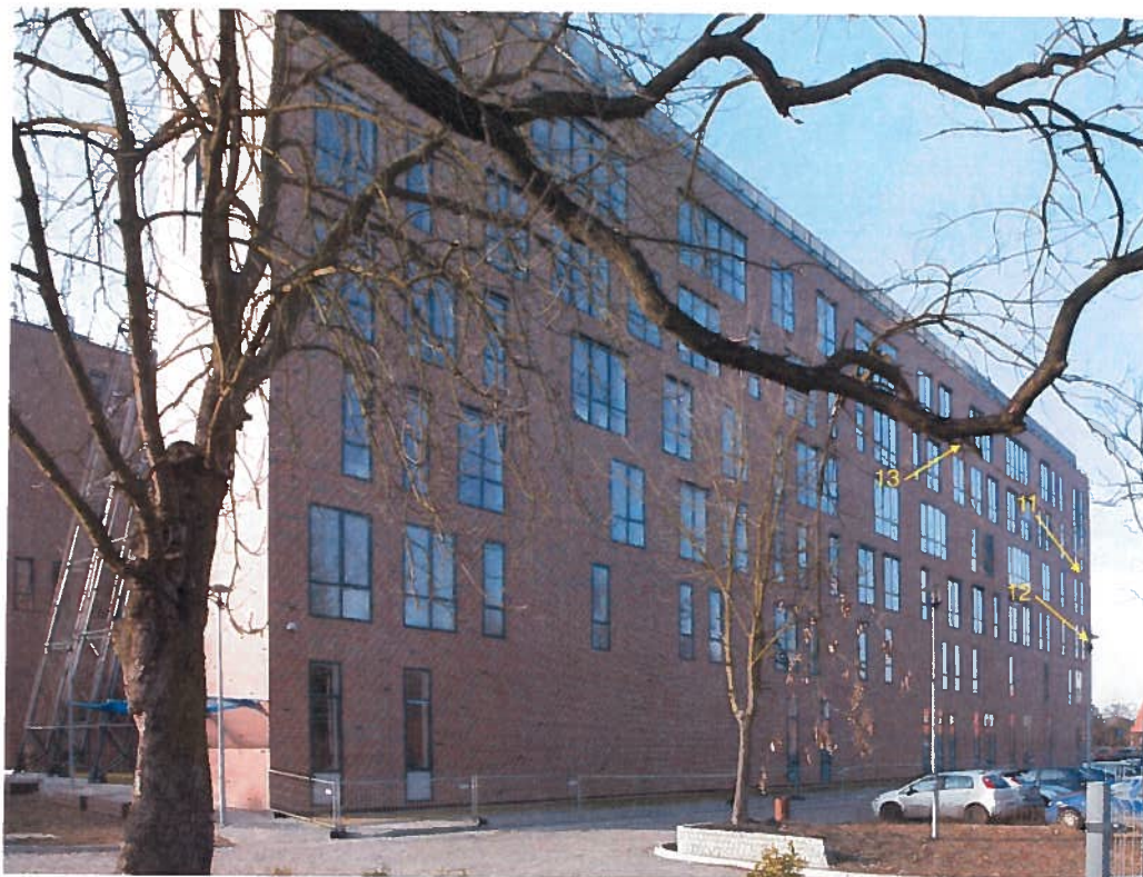
Fot. nr 5 Elewacja wschodnia
