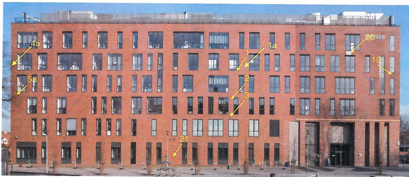
Fot. nr 1 Elewacja zachodnia z zaznaczonymi punktami kontrolnymi
