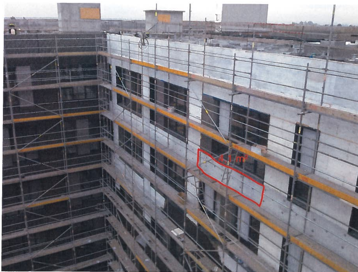
Fot. nr 44 Fragment elewacji północnej. (20.12.2013 r.)
