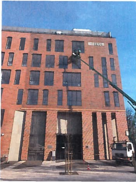
Fot. nr 36 Dostęp do punktu kontrolnego nr 20 Fot. nr 37 Odspojone płytki elewacyjne na pow. ok. 1,2 m 2 pkt. kontr. nr 20
