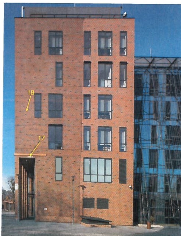
Fot. nr 7 Elewacja południowa osie ABC
