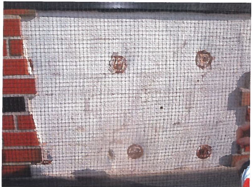
Fot. nr 36 Dostęp do punktu kontrolnego nr 20 Fot. nr 37 Odspojone płytki elewacyjne na pow. ok. 1,2 m 2 pkt. kontr. nr 20
