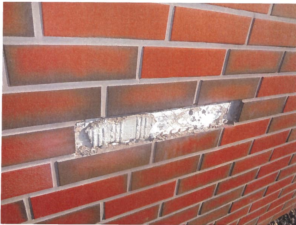
Fot. nr 39 Zdemontowane (odkute) 2 płytki elewacyjne elewacji zachodniej
