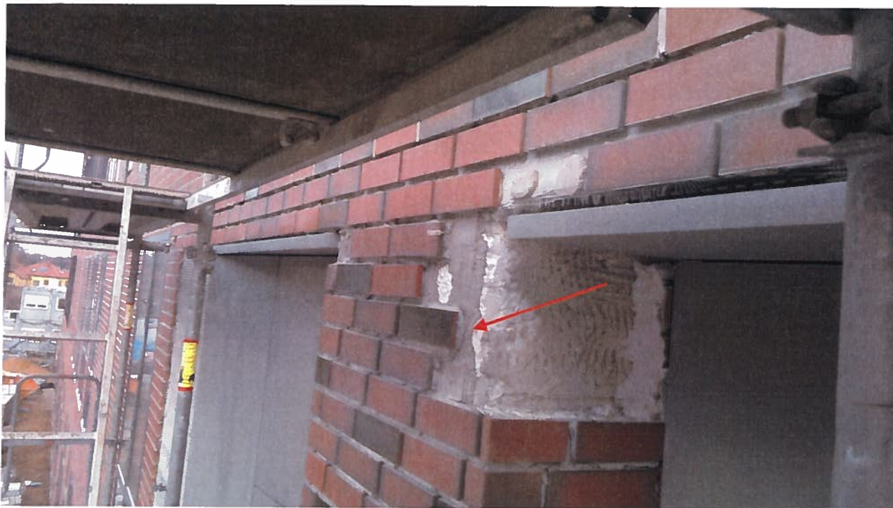
Fot. nr 45 Fragment elewacji zachodniej (05.12.2013 r.)
