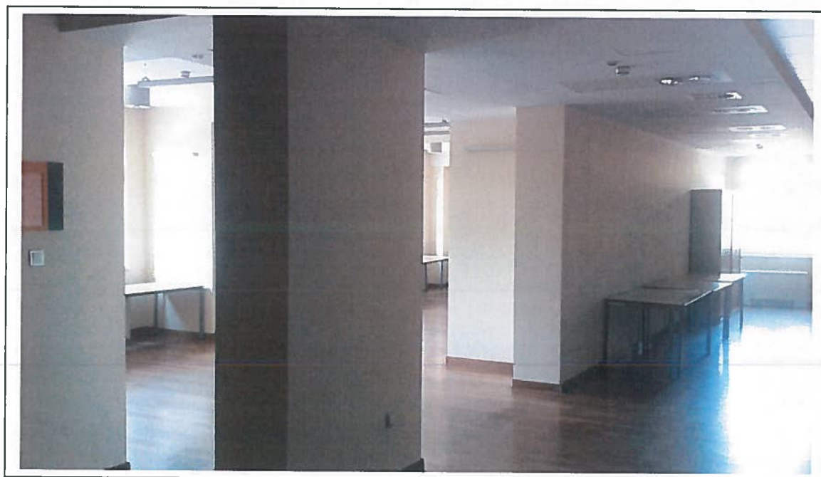
Widok pomieszczenia nr 1.9 I piętro bud 1A od strony korytarza
