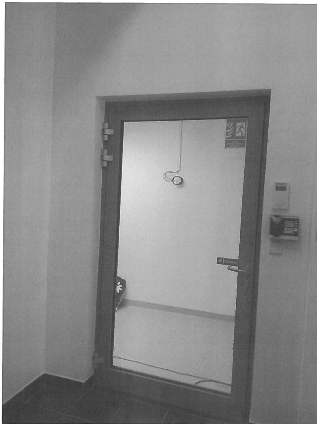
Fot. Miejsce montażu rolety 3
