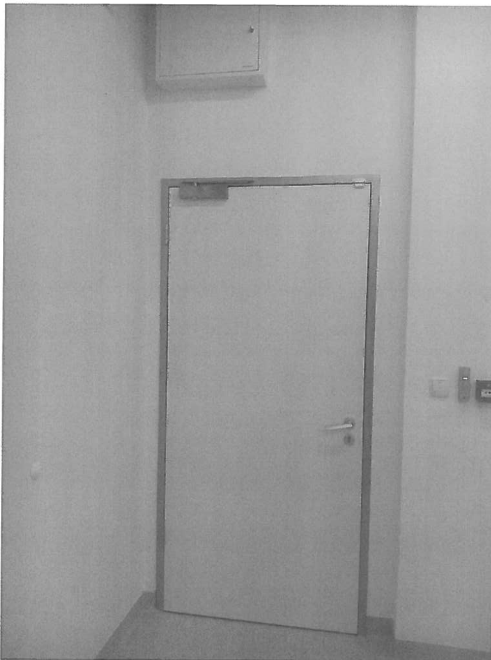
Fot. Miejsce montażu rolety 1
