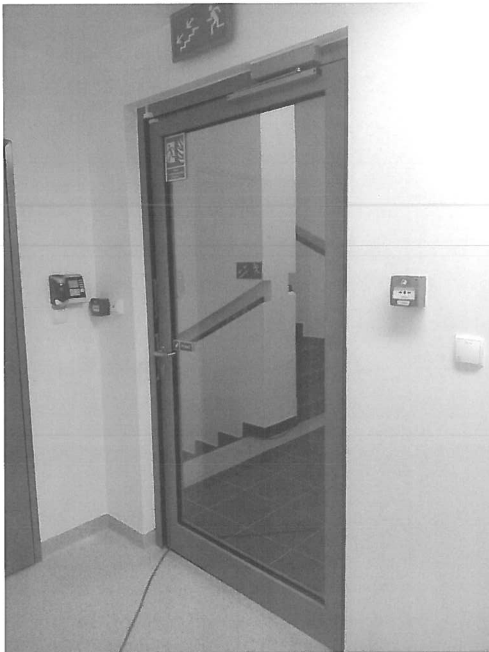
Fot. Miejsce montażu rolety 4
