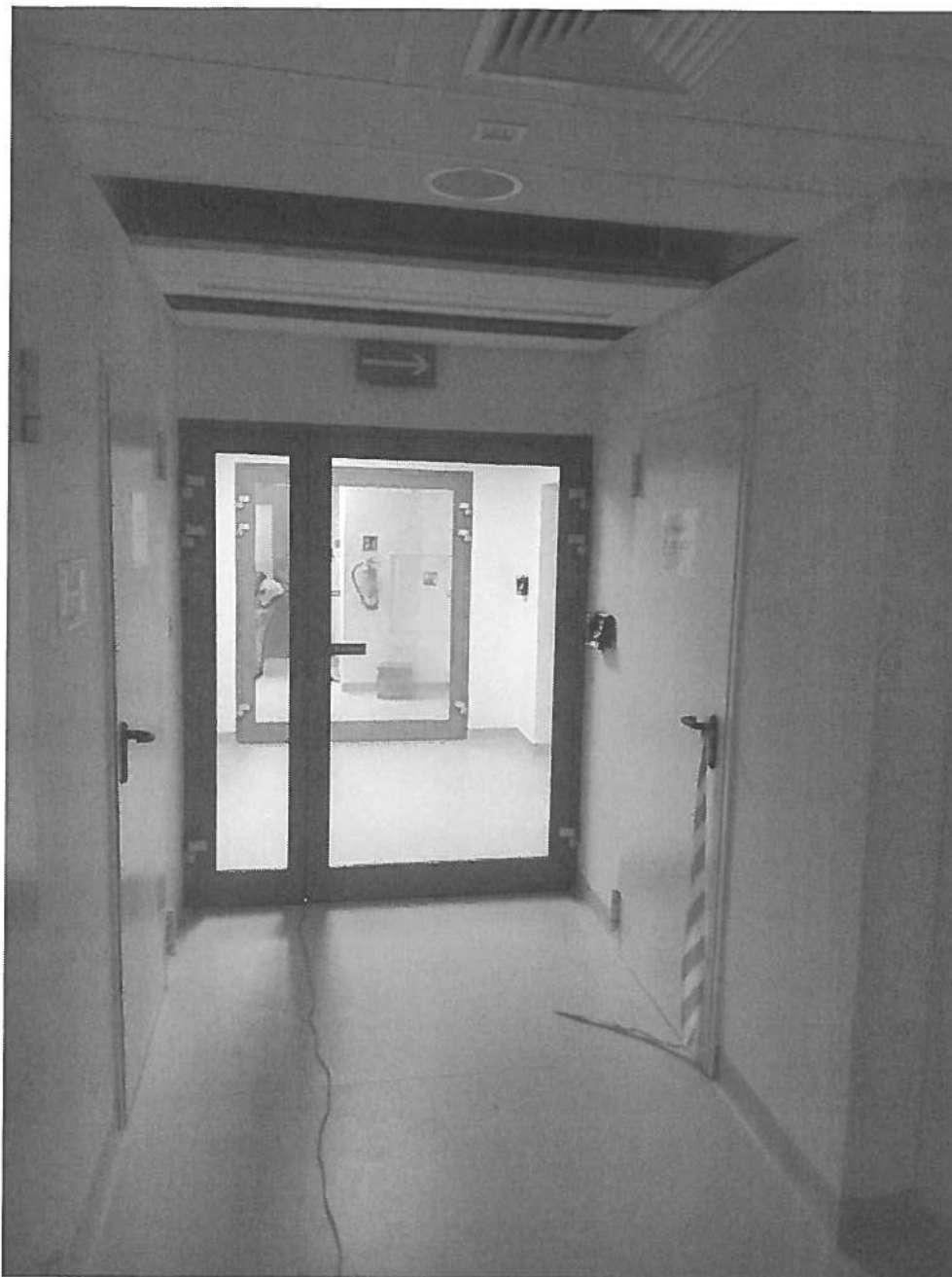
Fot. Miejsce montażu rolety 5 i 6
