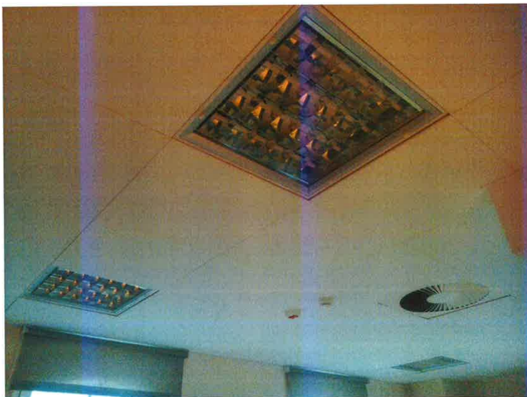
Fot. Pomieszczenie biurowe
